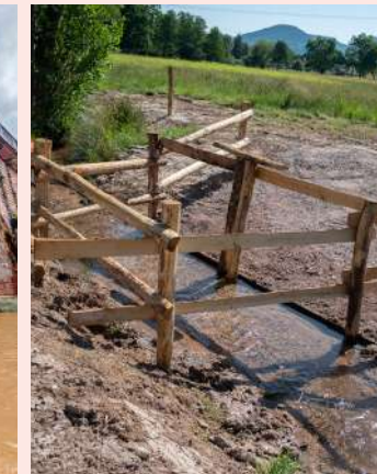
Restauration des continuités écologiques et installation de clôtures sur les berges de cours d'eau pour limiter le piétinement de la végétation par le bétail
