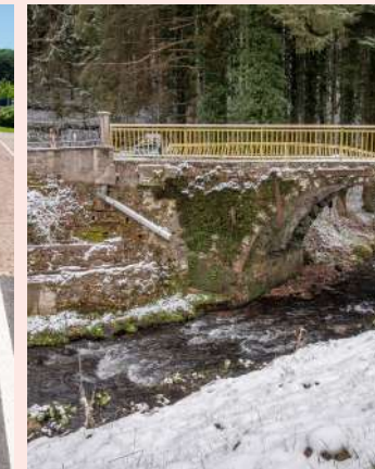
Soutien aux travaux du pont de la Folie à Moussey via le Fonds de concours de l'Agglo
