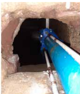
Renouvellement des conduites
