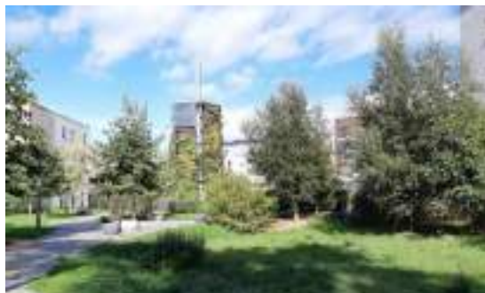
Bassin d'infiltration, éco-quartier d'Adelshoffen, Schiltigheim, Bas-Rhin - AERM
