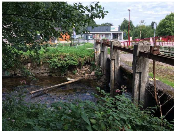
Restauration de la continuité écologique par la suppression d'un ouvrage en ruine, et protection de berge sur la Meurthe à Plainfaing en 2018 – photos ci-dessus avant travaux, et ci-dessous après
