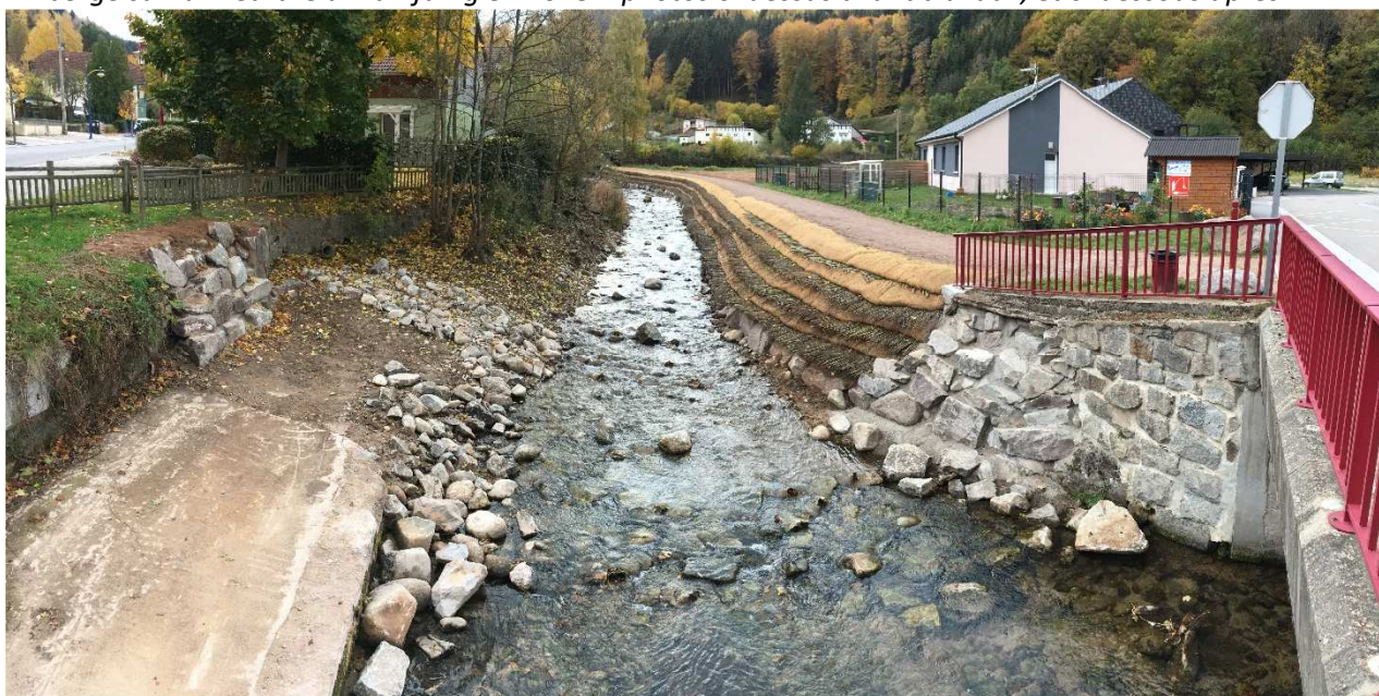
Restauration de la continuité écologique par la suppression d'un ouvrage en ruine, et protection de berge sur la Meurthe à Plainfaing en 2018 – photos ci-dessus avant travaux, et ci-dessous après
