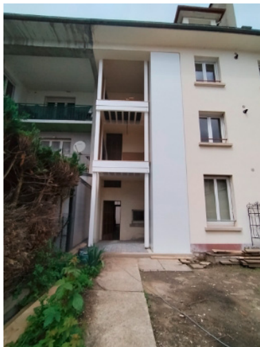
Réalisation de terrasses et rénovation en cœur de ville, subventionnées dans le cadre de l'Opération Programmée d'Amélioration de l'Habitat et de Renouvellement Urbain
